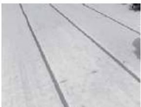
▲小屋裏への専用シート施工状況
